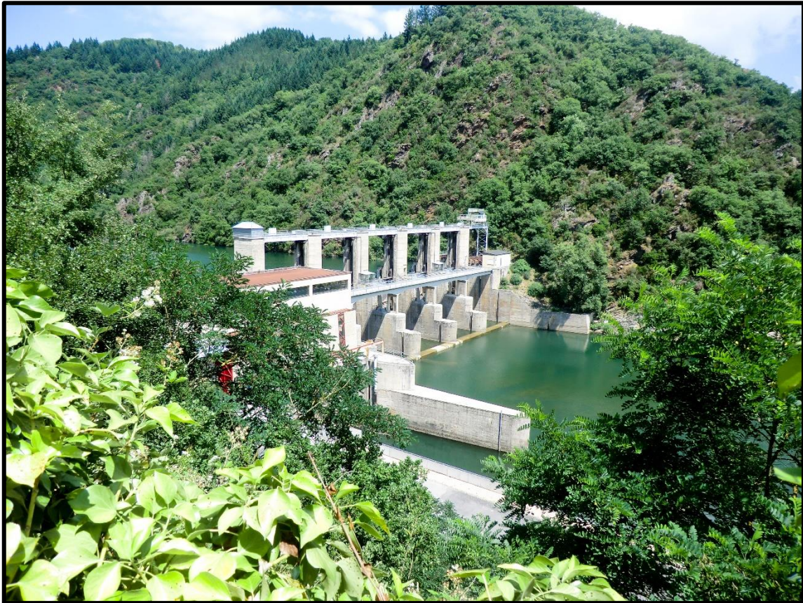
Barrage de la Jourdanie sur le Tarn, département de l'Aveyron, 2015. © Alice DENIS
